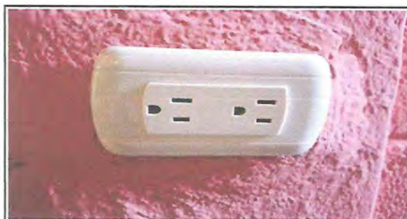
Foto 9. Sustitución de tomacorrientes concluido
