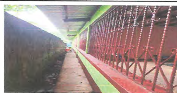
Foto 5: Pintura de balcones concluido
