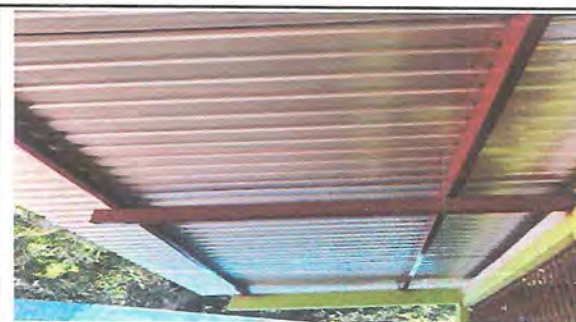
Foto 3: Sustitución de estructura metálica concluido.
