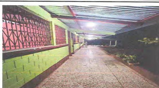
Foto 2: Pintura en todo el centro educativo concluido.
