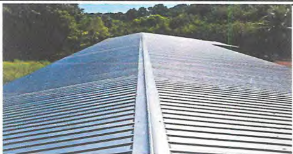
Foto 7. Sustitución de lámina por lamina troquelada concluido.
