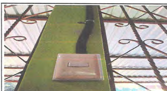
Foto 10. Instalación de timbre concluido.
