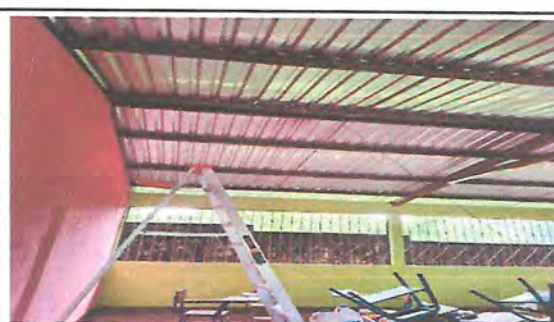
Foto 4: Sustitución de lámina por lámina troquelada concluido.
