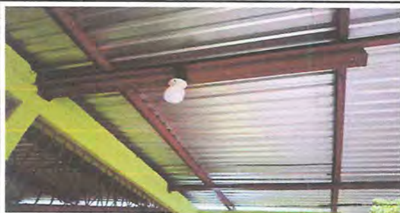
Foto 1: Sustitución de lámpara por fotos concluido
