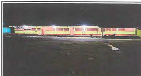
Foto 6: Sustitución del sistema eléctrico en toda la escuela.
